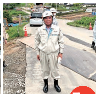
国道294号白河バイパス整備事業・南湖トンネル(白河市南湖～豊地)
